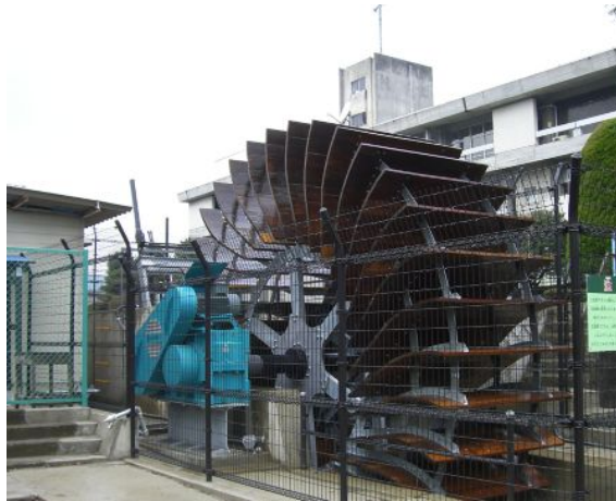
写真-6.6 水車型発電システム（都留市役所）
