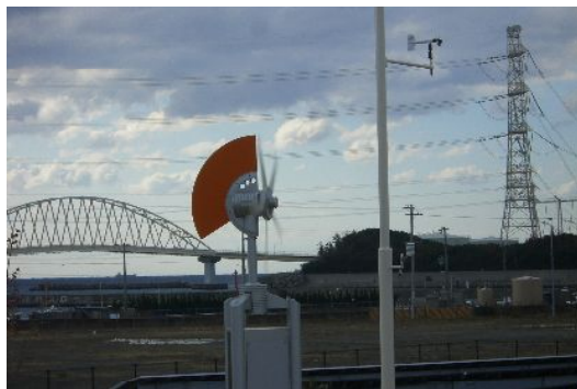
写真-6.5 200W 水平軸型（プロペラ型）風力発電設備の例 （関西電力(株)日高港新エネルギーパーク）
